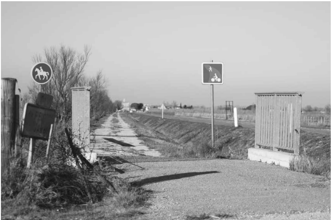
_ Après le Sambuc, l'ancienne voie ferrée, qui longe à cet endroit la route départementale s'est transformée en piste cyclable.
